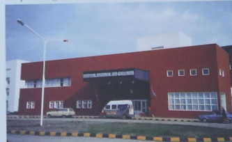
Hospital Regional de Río Gallegos
